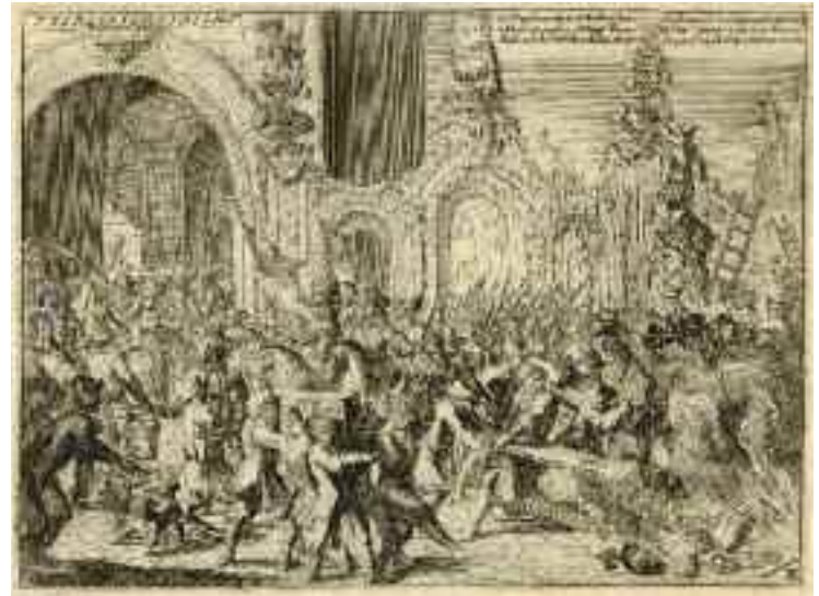
3 Het verbranden van de katholieke inventaris van de Dom na het vertrek van de Fransen in 1673. Ook deze afbeelding maakte deel uit van de reeks Uytrechts Veranderingen. HUA cat. nr. 39522.
