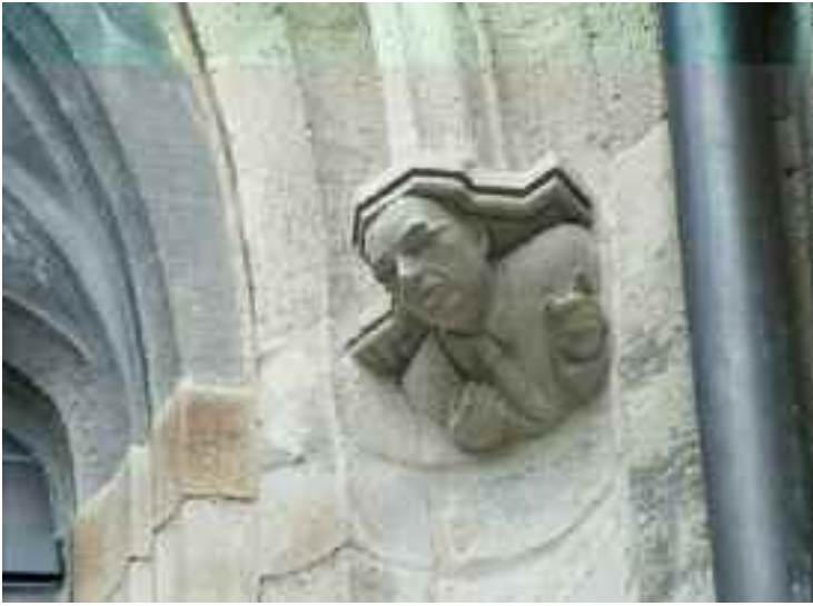
6 Restauratie-architect ir. T. van Hoogevest. Kraagsteen aan de zuidkant van de koorlichtbeuk. Foto RCE, Peter Cox 2013.
