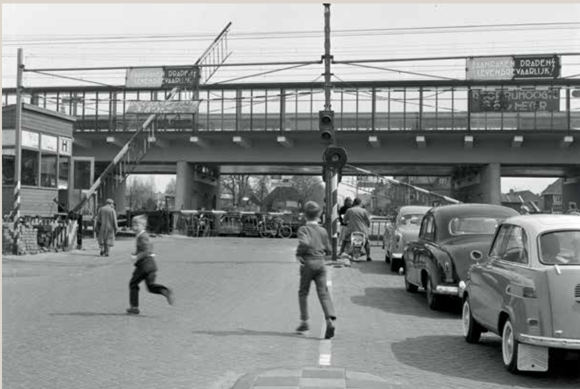
→ Nogmaals de overweg in de Zandvoortselaan te Heemstede, maar nu op 21 april 1958, wanneer het spoorwegviaduct met het nieuwe station erop in aanbouw is. De bomen gaan net omhoog, de jongetjes kunnen nog net op tijd naar de overkant.
