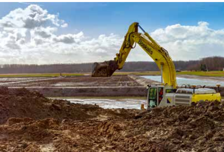
Aanleg van nieuw rietmoeras aan de kant van het Drontermeer.
