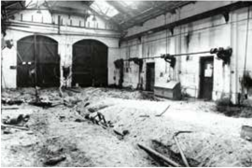
Utrecht, Centrale Werkplaats, 1945.
