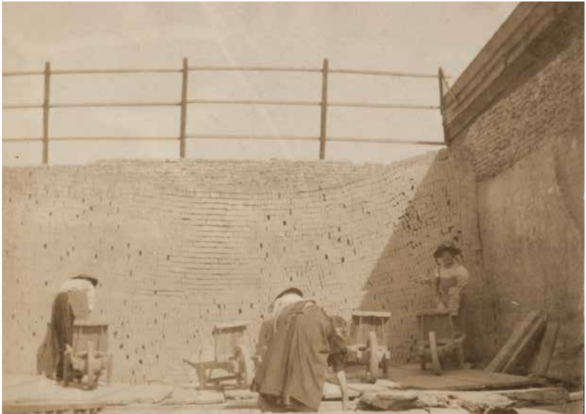
afb. 169 Uitkruien van een steenoven op een IJselsteenfabriek, ca. 1908, foto IISG
