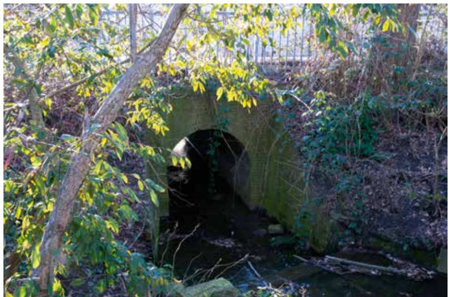
Duiker over de (omgelegde) Stakenbeek te Oldenzaal; 22 maart 2015.
