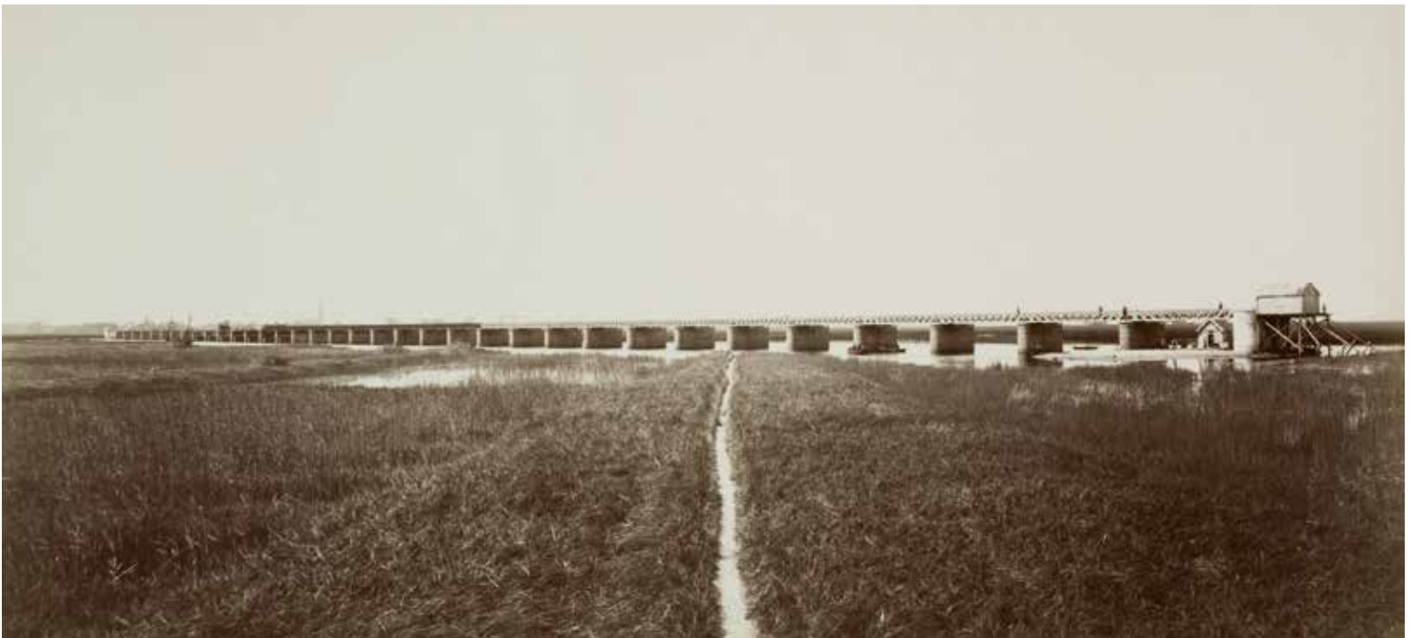
De bouw van de 600 meter lange brug over het Bossche Inundatieveld in 1884. Collectie Spoorwegmuseum.
