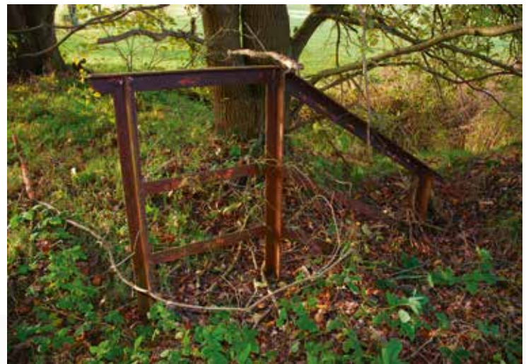
Een van de vele originele overweghekjes tussen Leusden en De Haar uit de aanlegtijd van de spoorlijn die het merkwaardig genoeg overleefd hebben. De rood/witte beschildering is nog vaag herkenbaar; 8 november 2008.
