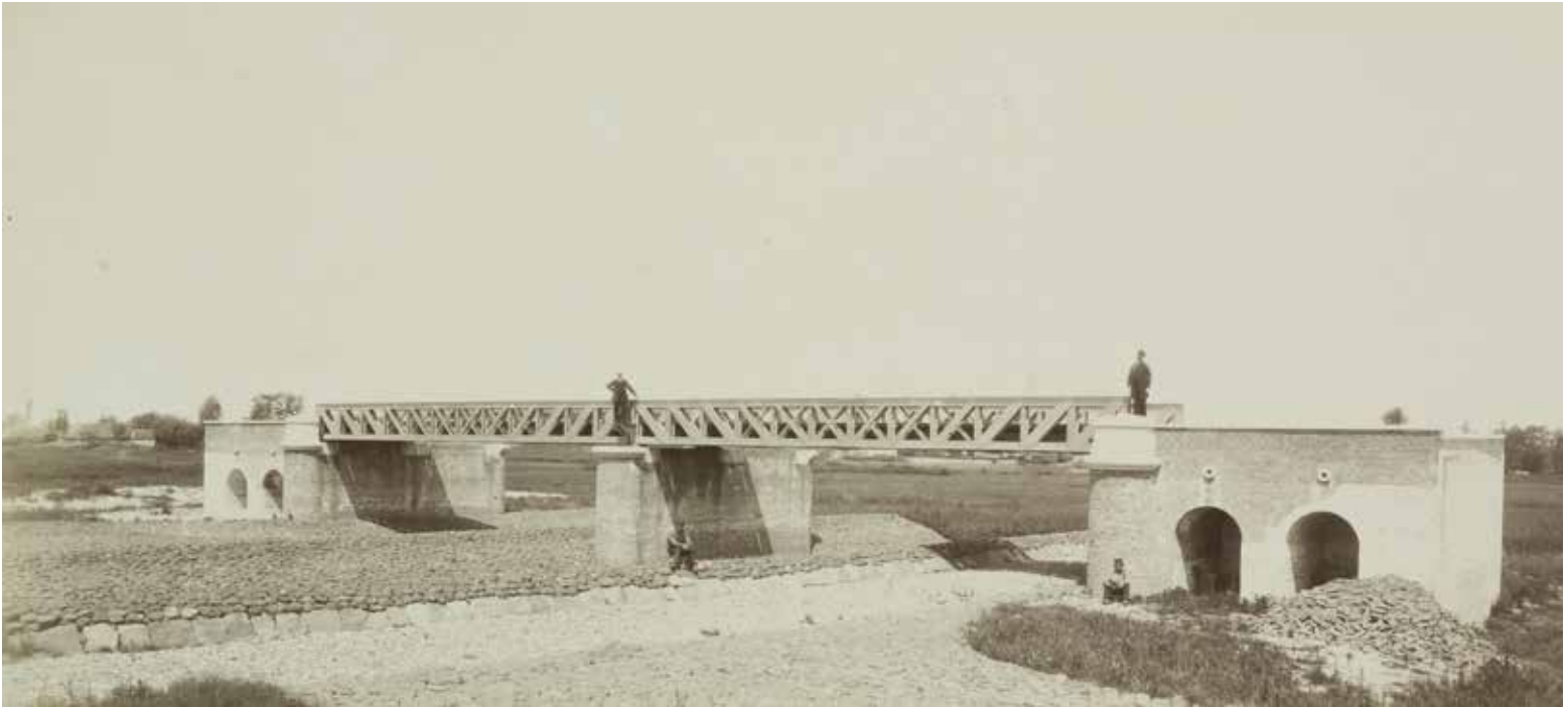
De bouw van de spoorbrug over de Bossche Sloot bij Vlijmen in 1885. Collectie Spoorwegmuseum.
