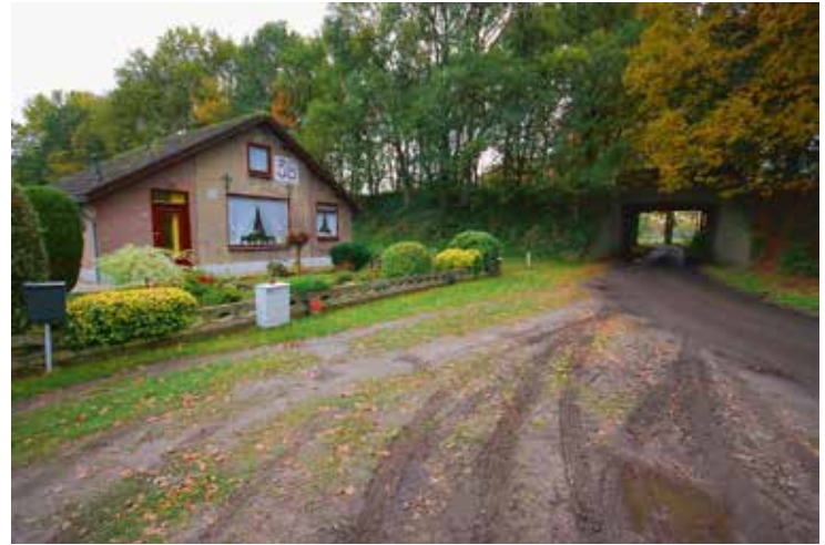
Wachtpost 38 aan de Oudenhorsterlaan ten zuiden van Woudenberg, een van de relatief vele bewaard gebleven wachtposten langs de lijn. Rechts een viaduct in de spoorlijn die hier al aardig op hoogte ligt in de klim naar het viaduct bij De Haar; 2 november 2008.
