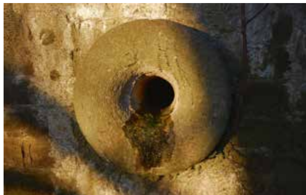
Druipsteen in het oostelijke landhoofd van de brug over de Bossche Sloot; 12 januari 2008.
