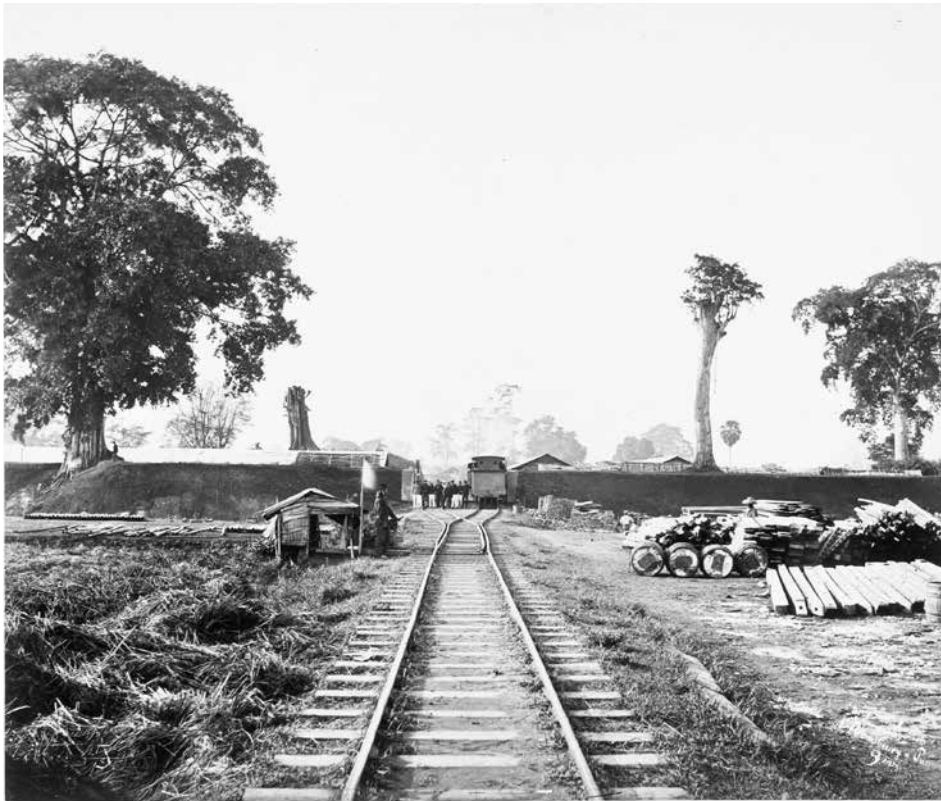
Zo kwam de eerste tramlijn van de rede van Olehleh de kraton van Kota Radja binnen. Het is het 1067 mm spoor met een primitieve handwissel, waar de wisselwachter in een soort hutje kon schuilen tegen zon en regen. Foto van 1877.
