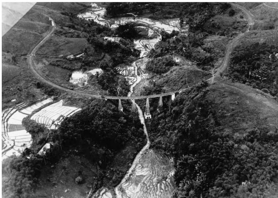
De spoorlijn door de Preanger Hooglanden stond bekend om de prachtige bruggen en viaducten, wonderen van techniek. Een vroege luchtfoto uit de jaren dertig van het hoge viaduct over de rivier de Tjipoda.
