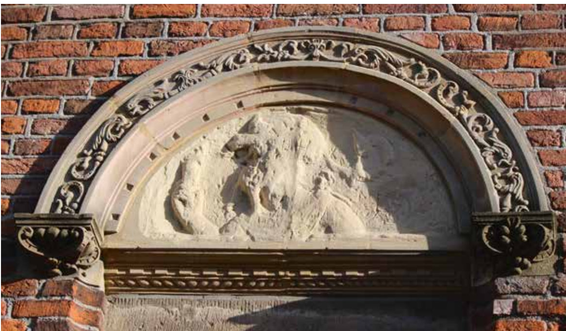
2.30 Zaltbommel, Maarten van Rossumhuis, mergelstenen bekroning van het kloostervenster in de westgevel op de begane grond
