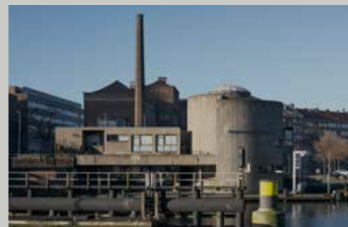
18 Gemaal Parksluizen ROTTERDAM 125
