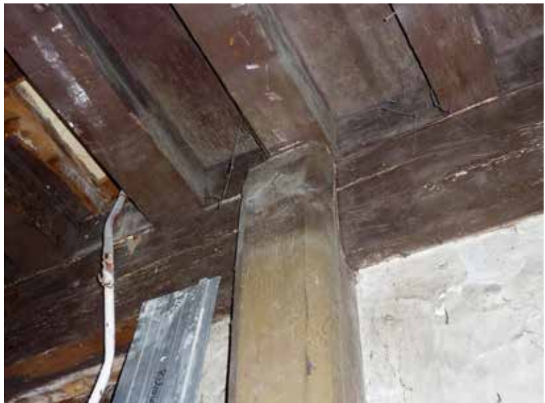
16 De verstijvingsstijl op de verdieping in Koornmarkt 111 sluit aan tegen de strijkbalk langs de voorgevel. (wfw)
