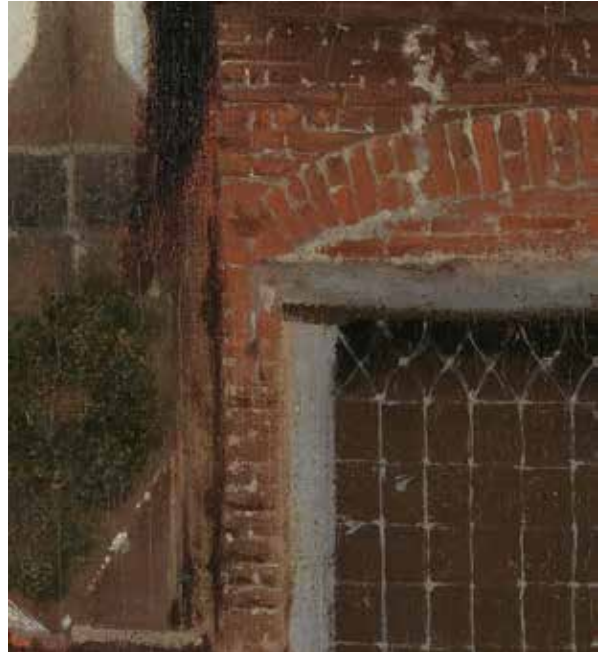
18 De ontlastingsboog van het linkervenster overspant de bovendorpel niet volledig om niet te dicht bij de hoek uit te komen. (RMA)
