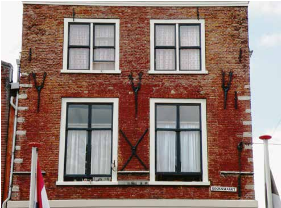
14 Detail voorgevel Koornmarkt 111. De uit de bouwtijd daterende gevorkte ankers zijn aan de uiteinden versierd met een 'fleur-de-lys-motief'. Het kruisvormige anker is later toegevoegd als verankering van de stijl tegen de binnenzijde van de voorgevel. (wfw)
