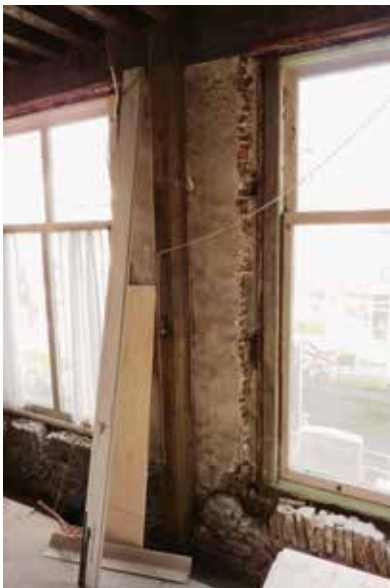
15 In Koornmarkt 111 staat een verstijvingsstijl op de verdieping tegen de binnenzijde van de voorgevel. (wfw)
