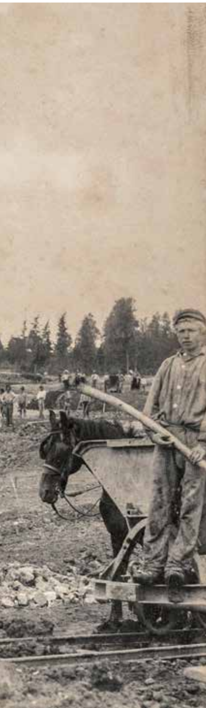
Arbeiders poseren tijdens de werkzaamheden voor de aanleg van de vijverpartij en het beoogde grondreliëf voor het park van Kasteel de Haar, circa 1896
