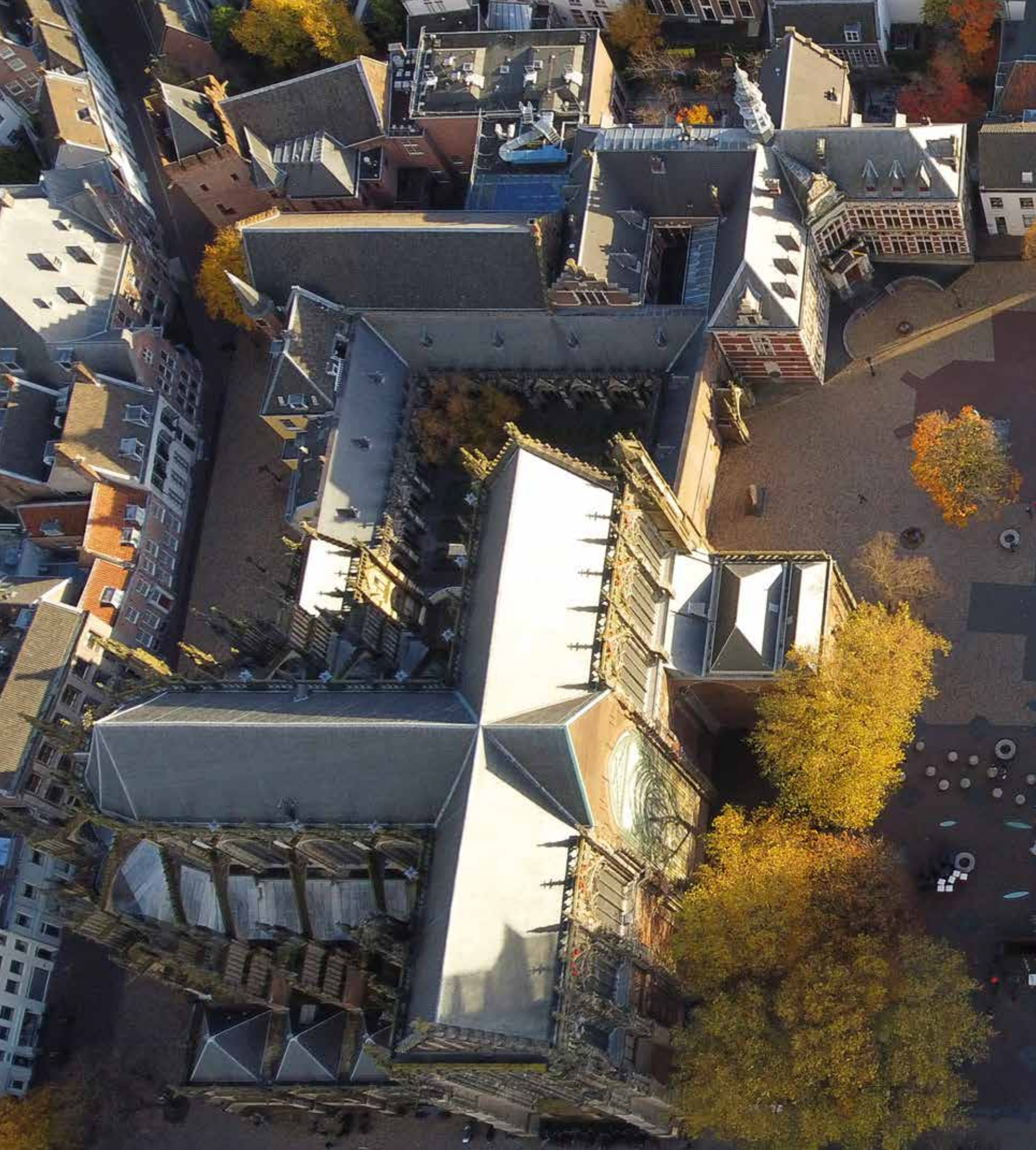
Utrecht, Domplein. Het bovenste stukje Domtoren kwam eind 2023 weer uit de steigers. Foto: D. Claessen en H. Wynia / Erfgoed Utrecht, 2023.
