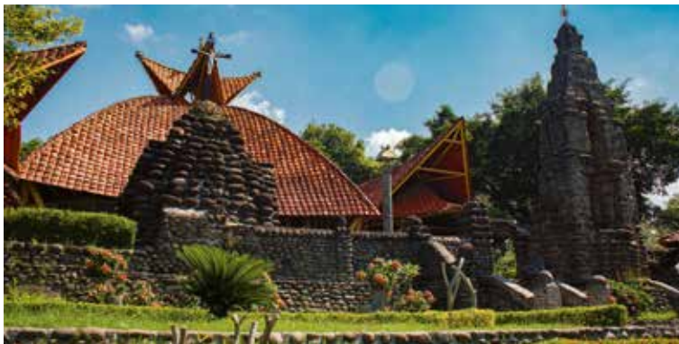
afb. 61 Henri Maclaine Pont, Kerkgebouw te Pohsarang, Pohsarang (regio Kediri), Jalan Raya Puhsarang , 1937, voorzijde gebouw, foto geeft situatie weer uit 2017. Foto: Ranitheresia.
