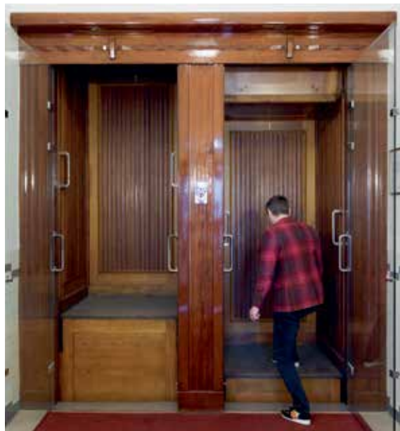
De vier Paternosterliften zijn nog altijd in werking. Omdat men niet meer gewend is aan dergelijke doorlopende liften zijn ze afgesloten met glas.
