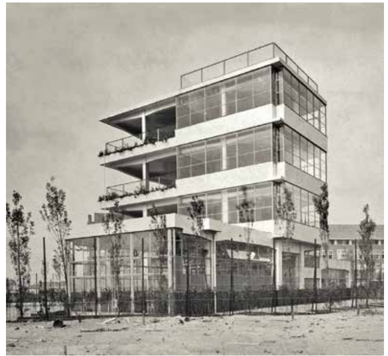
[B] ir. Jan Duiker ■ Openluchtschool voor het gezonde kind ■ Cliostraat 38-40, Amsterdam ■ 1930 ■ De school voordat deze werd ingebouwd in een woonblok
