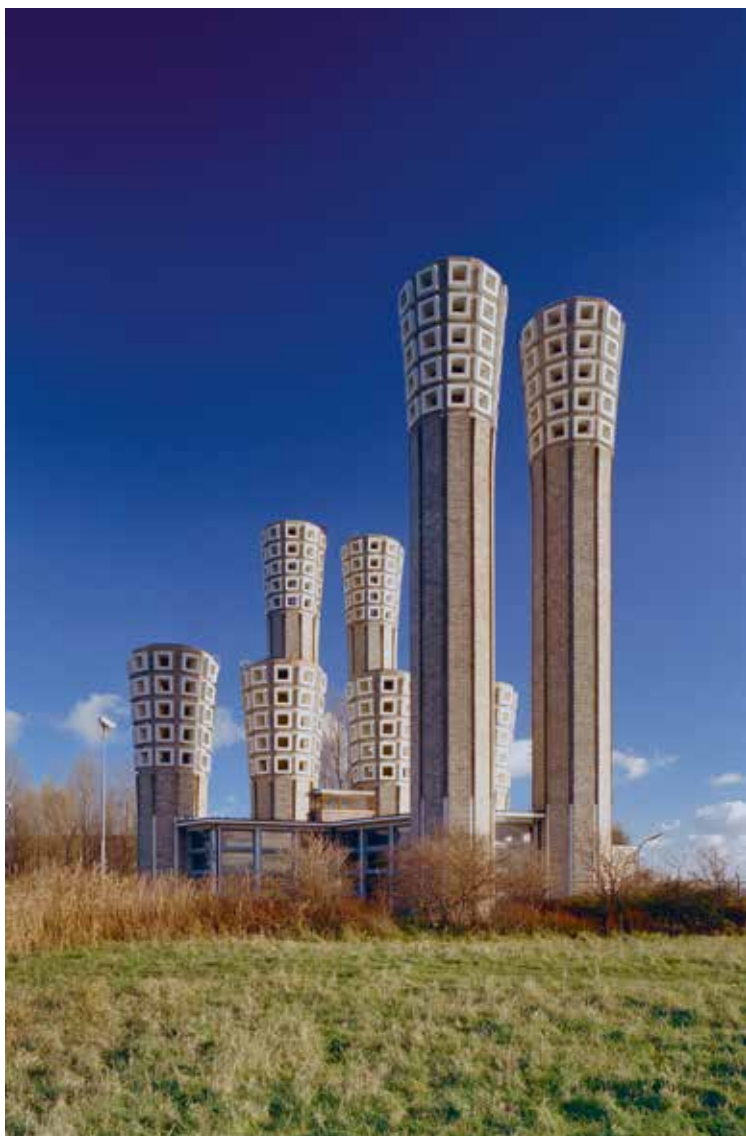
Ventilatiegebouw van de Velsertunnel Velsen
