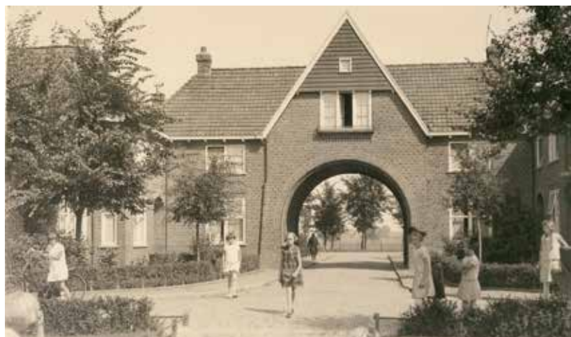
Poortgebouw De Hoogte | 1931
