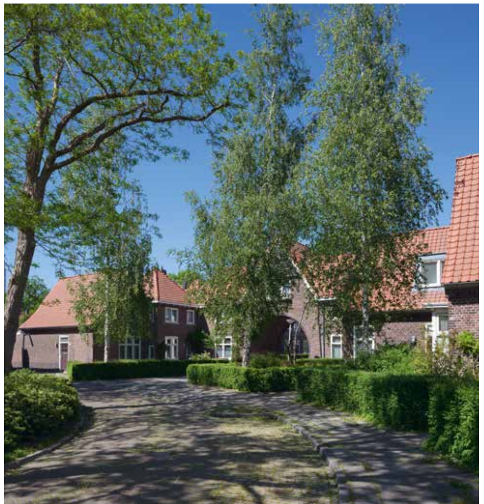
Poortgebouw De Hoogte
