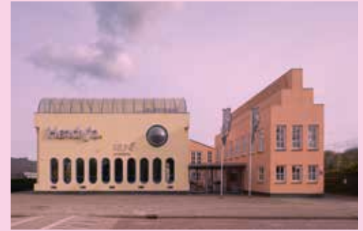
12 Bedrijfspannen Havendijk Tilburg | 161
