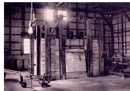
▲ Vanaf het bgein producerde Nikon optisch glas. In 1923 begon Nikon echter met de bouw van een glasoven voor research-doeleinden, die een capaciteit had van 500 kilo. Die research bleek een zeer groot voordeel bij het ontwerpen van objectieven (foto: Nikon).
