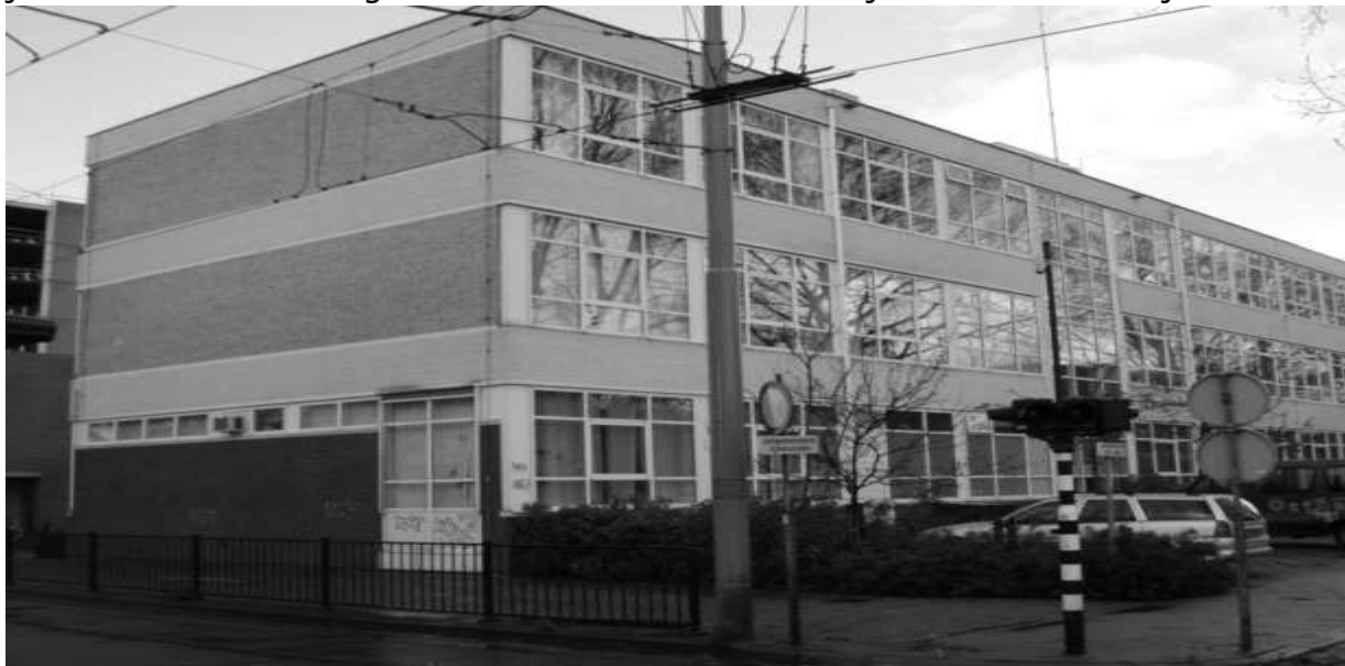
Voormalige keuringsgebouw van Bleyswijkstraat te Delft
