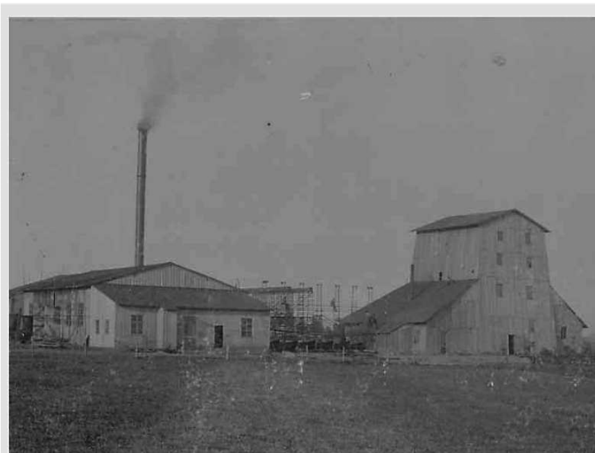
Van links naar rechts: Bevriesloods met locomobiel (schoorsteen) bij boortoren schacht II. Midden achter in aanbouw het tijdelijke gebouw met elektrisch onderstation.
