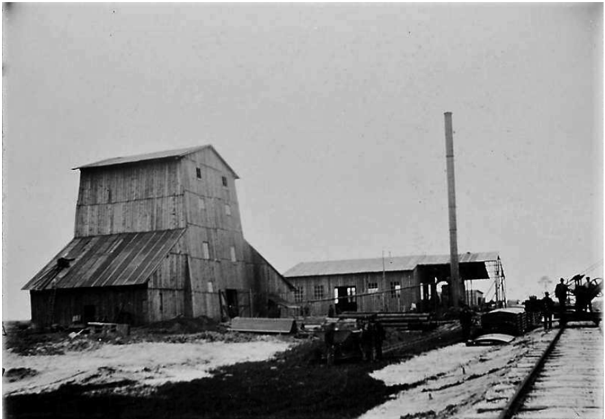
Schacht 2: Het gebouw links is het schachtgebouw met lieren en grondwaterpompen. In het rechtergebouw bevindt zich de bevroesinstallatie en de locomobiel: dit is een vlampijpketel met stoomketel die de benodigde elektriciteit opwekt voor de bevroesinstallatie, pompen en lieren. De lange schoorsteen voert de verbrandingsgassen van de locomobiel af. Helemaal rechts het kraanspoor met de verplaatsbare handwagenkraan. Dit is de allereerste foto van Staatsmijn Wilhelmina.
