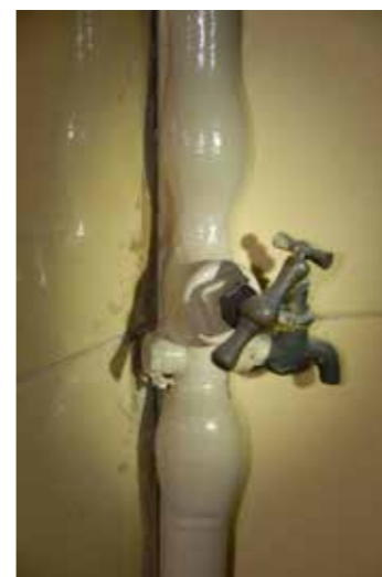
Figuur 1.14 Loden leidingen zijn vaak dikke en kronkelige buizen, zonder koppelstukken maar met verdikkingen aan kruispunten. (Bron: www.zorg-en-gezondheid.be )
