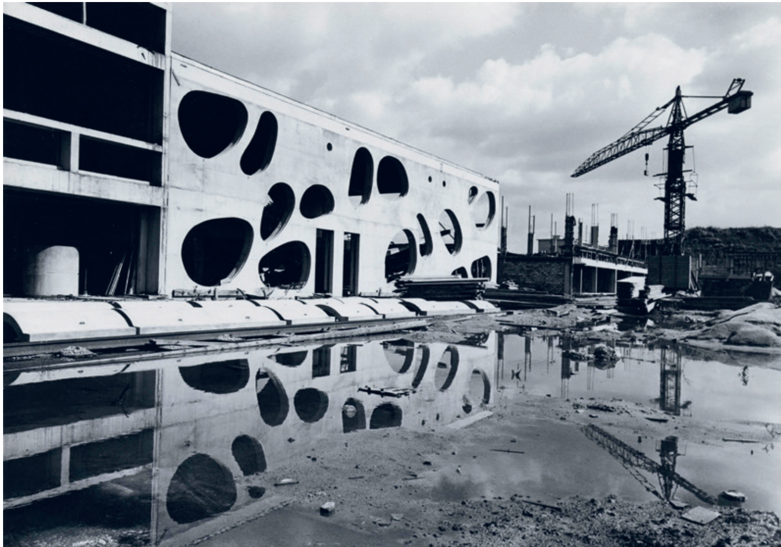
De iconische betonnen voorgevel van Stynen wordt opgetrokken.
