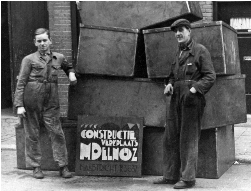
Willy (links) bij machineconstructiebedrijf Delnoz, Maastricht
