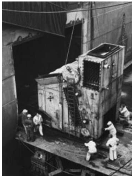
De nieuwe ketels worden geplaatst (Foto: vereniging de Lijn)
