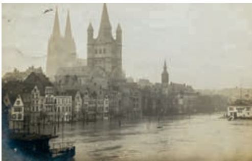
Flooding in Cologne, Frankenwerft, 1920.
