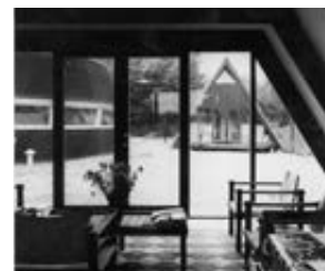
fig.12 Zicht op het hoofdatelier en een residentiewoning van het Frans Masereel Centrum, ca. 1979 (FA)
