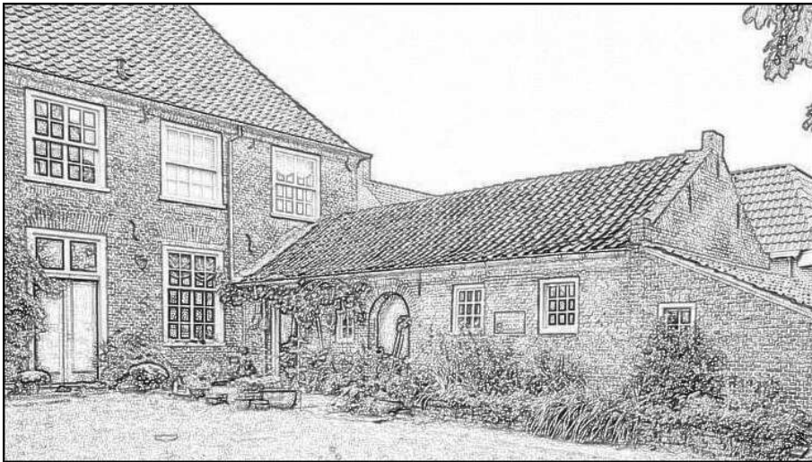
Afb. 5 Achterkant van de pastorie in Nuenen, In de aanbouw had Vincent zijn atelier
