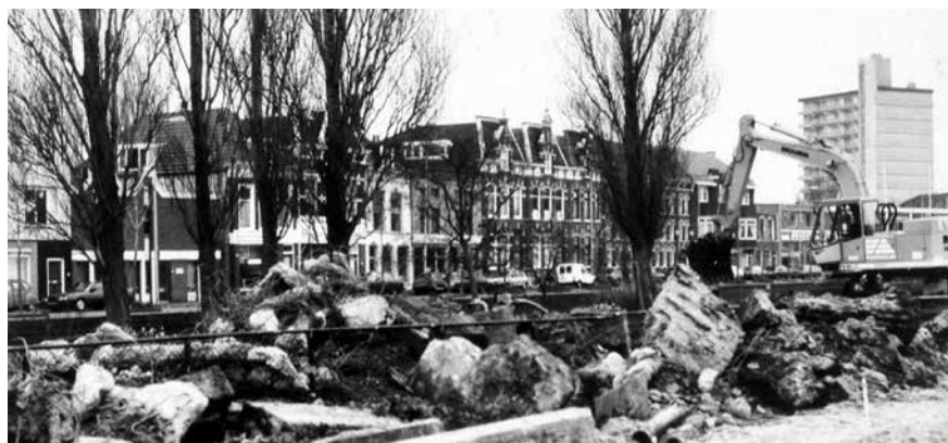
Restanten van de oude stadsmuur worden in 1985 opgeruimd ter hoogte van de Nieuwe Marktpassage (het voormalige Veemarktterrein). In de verte is de Panoramaflat langs de Karnemelksloot te zien.
