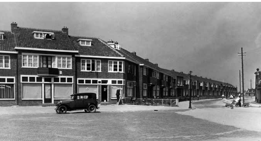
♣ Woningbouw en wegverbetering aan Onder de Boompjes in 1933.
