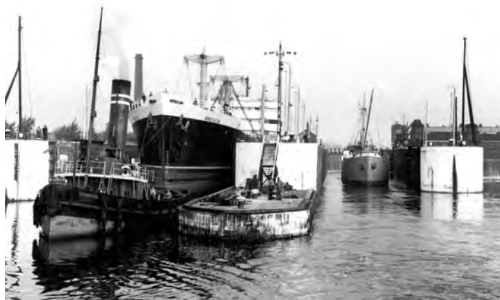
Op weg naar Manchester zien we de 'Att-S' in de sluis van Irlam in het Manchester Ship Canal op 18 september 1954. De romp inmiddels grijs geschilderd. Links in de grotere sluis zien we de in 1905 bij J.P. Rennoldson & Sons in South Shields gebouwde 28 meter lange stoomsleper 'Cornbrook' van Manchester Ship Canal Company. De stoomsleper had een single triple-expansie stoommachie van 700 ihp. De 'Cornbrook' verleent assistentie aan de 'Brescia' bij het verlaten van de sluis. De 'Cornbrook' werd in 1963 verkocht voor sloop aan een sloopwerf in Garston (district Liverpool). De 'Brescia' was van het type CI-M-AV1 en gebouwd als 'Hickory Isle' bij Consolidated Steel Corp in Wilmington, USA. Het 103 meter lange 5032 ton metende standaardchip werd op 20 juli 1945 opgeleverd.
