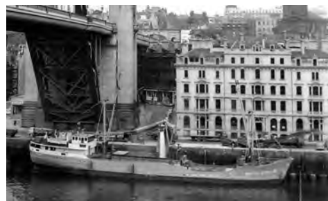
Graan laden in Newcastle vlak voor de Tyne Bridge. De stalen doorgaande boogbrug over de Tyne werd ontworpen door het ingenieursbureau Mott, Hay en Anderson en 10 oktober 1928 geopend door Koning George V. Collectie auteur.
