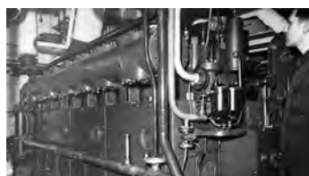
De 8 cil. Werkspoor dieselmotor van 500 pk gaf tijdens de technische proefvaart een snelheid van tussen de 11 en 12 knopen. De gemiddelde snelheid van de 'R.P.S.' die de Werkspoor motor leverde was 10 knopen. Maar veel hield af van de weersomstandigheden tijdens de vaart. Collectie auteur.
