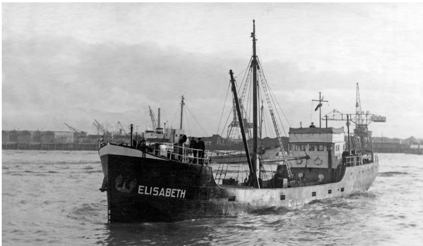
In 1947 werd de 'Elisabeth' verbouwd bij A. Vuyk & Zonen's Scheepswerven in Capelle aan den IJssel. Goed is te zien dat de achteropbouw met stuurhuis grondig is aangepakt. Ook de schoorsteen werd iets korter. Collectie auteur.
