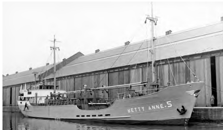
De 'Betty Anne-S' liggend in Liverpool. Beide (zuster) schepen hadden vier laadbomen van elk 3-ton. Een matroos zet staande op het bootsmanplankje het achterschip in de witte verf. Collectie auteur.
