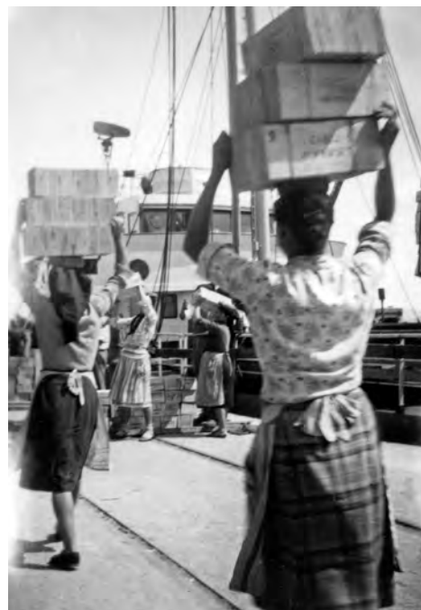
In een aantal Europese landen was het gebruikelijk dat vrouwen werden ingezet bij het laden en lossen van houtschepen. Op de foto van juli 1956 zien we vrouwen vanuit een loods op de kade gebundelde plankjes hout op hun hoofd naar het schip brengen. Daar werden de bundels in een net met eigen laadgerei aan boord gezet.
