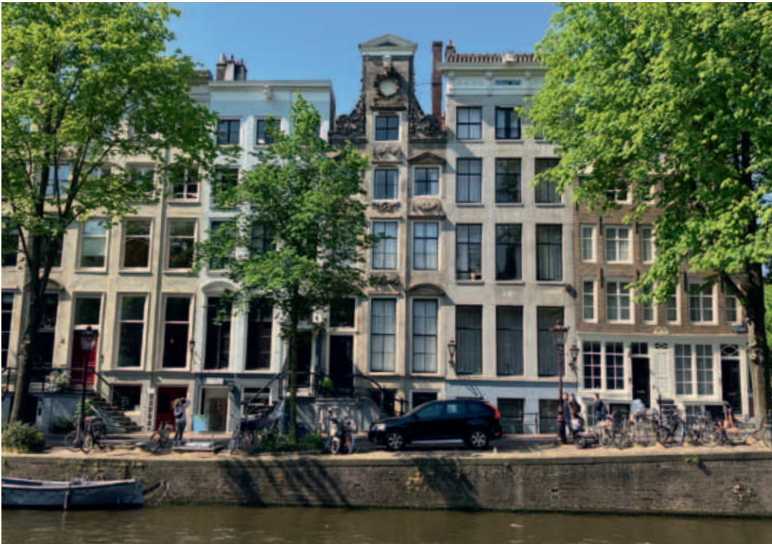
Fig. 4. Herengracht 400 (het rechterhuis, met de rechte daklijst), het woonhuis van Temminck in Amsterdam.
