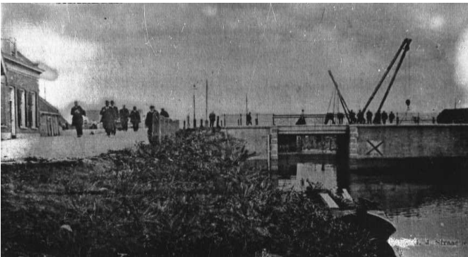
Spoorbrug over de Charloise haven
