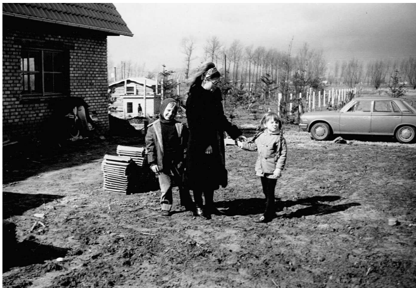
1971 - De in aanbouw zijnde villa langs de Koning Albertlaan, bewaakt door Rex, een gevaarlijke Dobberman.
