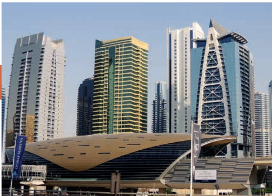
Het metrostation nabij Dubai Marina.
