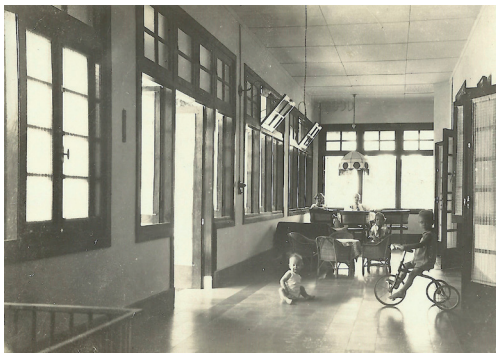
Tjoeroeg 1930: Besar, woongalerij. Links deuren naar de achtertuin. Rechts openstaande deuren van eetkamer en Leo's kamer.
