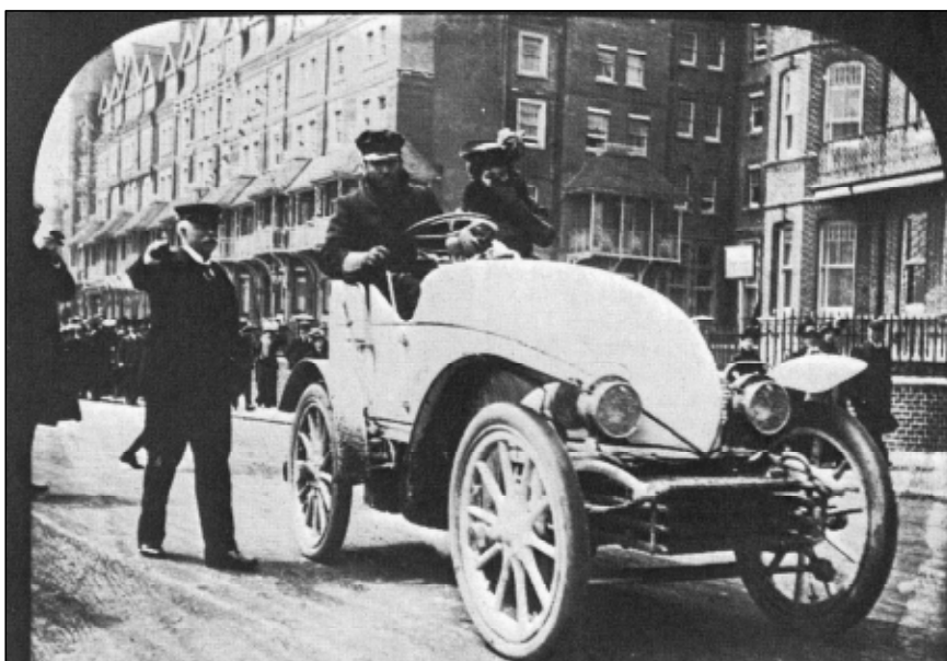
Serpollet stoomwagen met de bijnaam 'Paasei'. Op 13 april 1902 verbeterde Léon Serpollet er in Nice het wereldsnelheidsrecord op land mee met 120,805 km/u. (Coll. Auteur).
