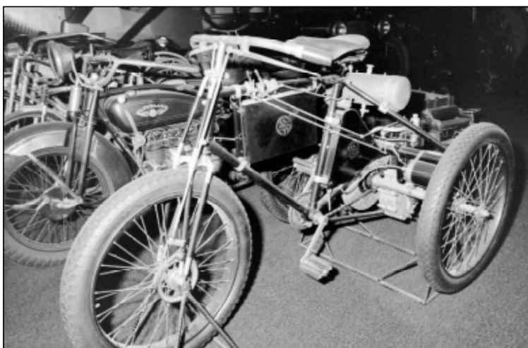
1899 De Dion Bouton driewieler type M9. De ontsteking werkte via een hoogspanningsmagneet; een onderdeel waarmee het bedrijf in Puteaux, Seine, een primeur had. Leeg gewicht circa 80 kilo, topsnelheid ongeveer 45 km/u bij een verbruik van een liter per 35 kilometer. (foto auteur).
