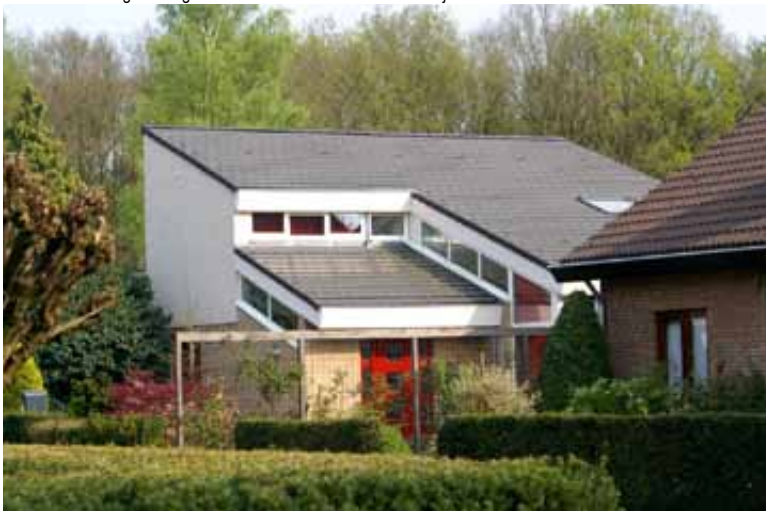
Woningverbouwing / reconstructie - Waalwijk
