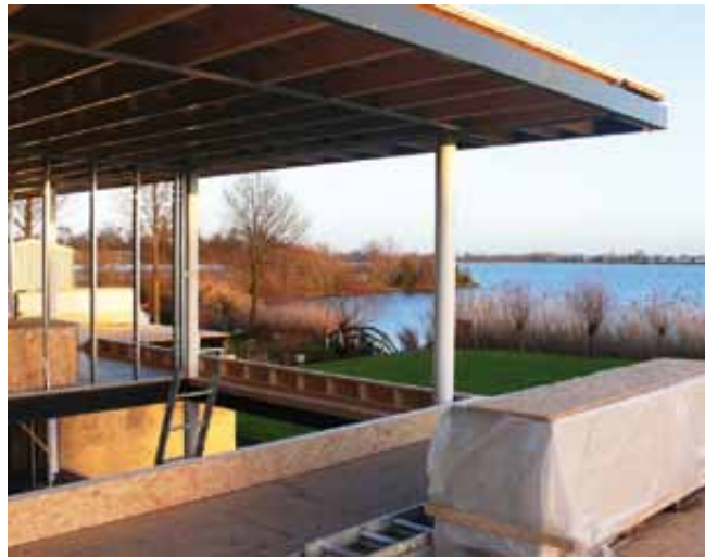
Woonhuis zicht op het water vanaf de woning in aanbouw - Ter Aar
