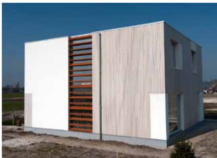
Montagewoning - De Contreie, Oosterhout
