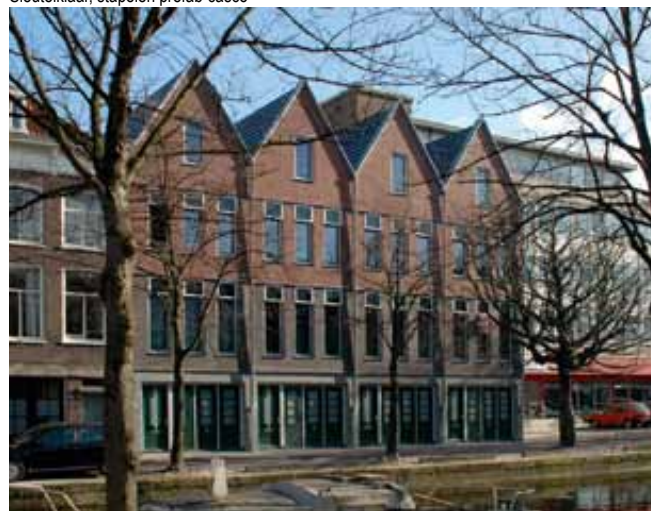
Gevels - Boomsluiterskade, Den Haag
