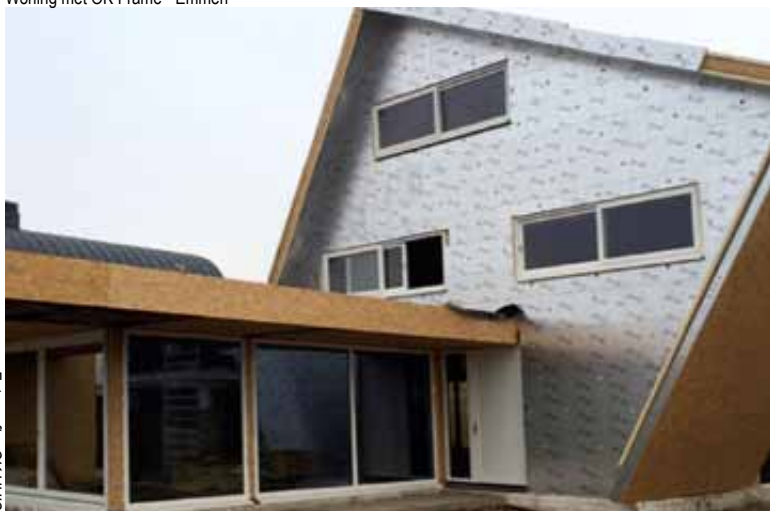
Woning met OK Frame - Oegstgeest
