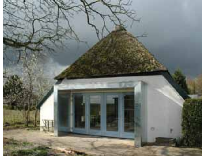
Verbouwing boerderij, interieur en exterieur
