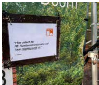
Slot op bouwhek: bouw ligt stil i.v.m. faillissement aannemer Bink Bouw
