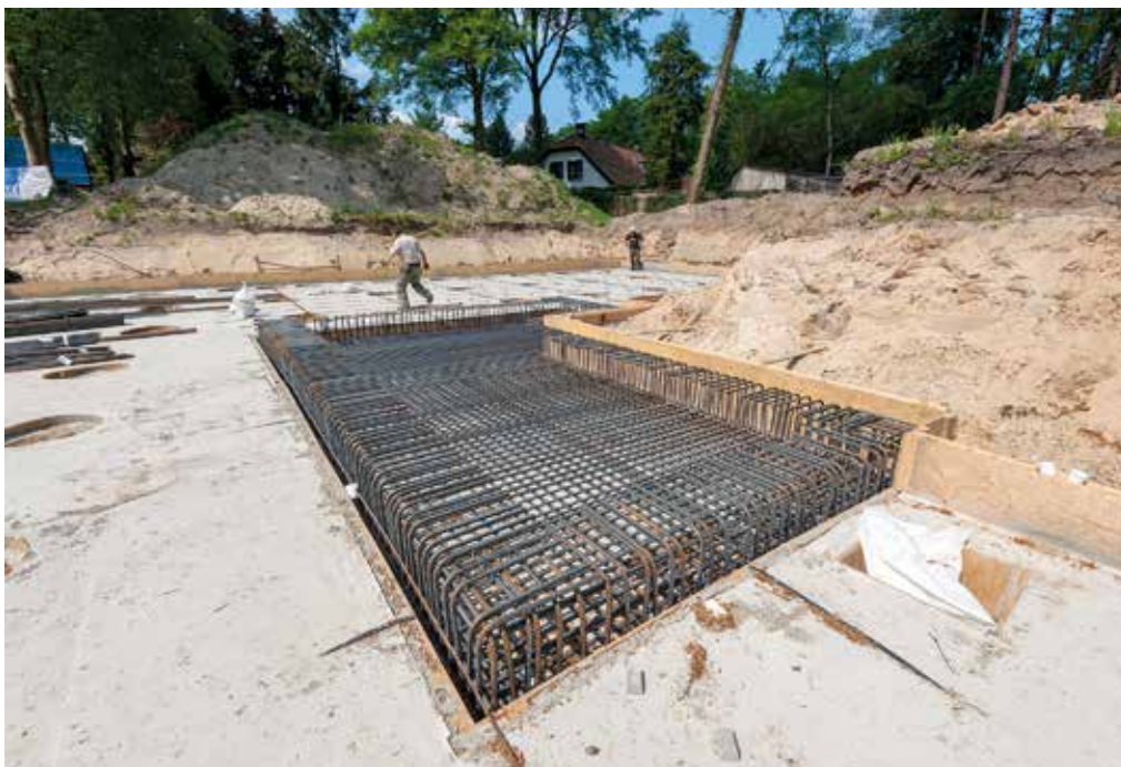
De wapening van de vloer rond het trappenhuis
