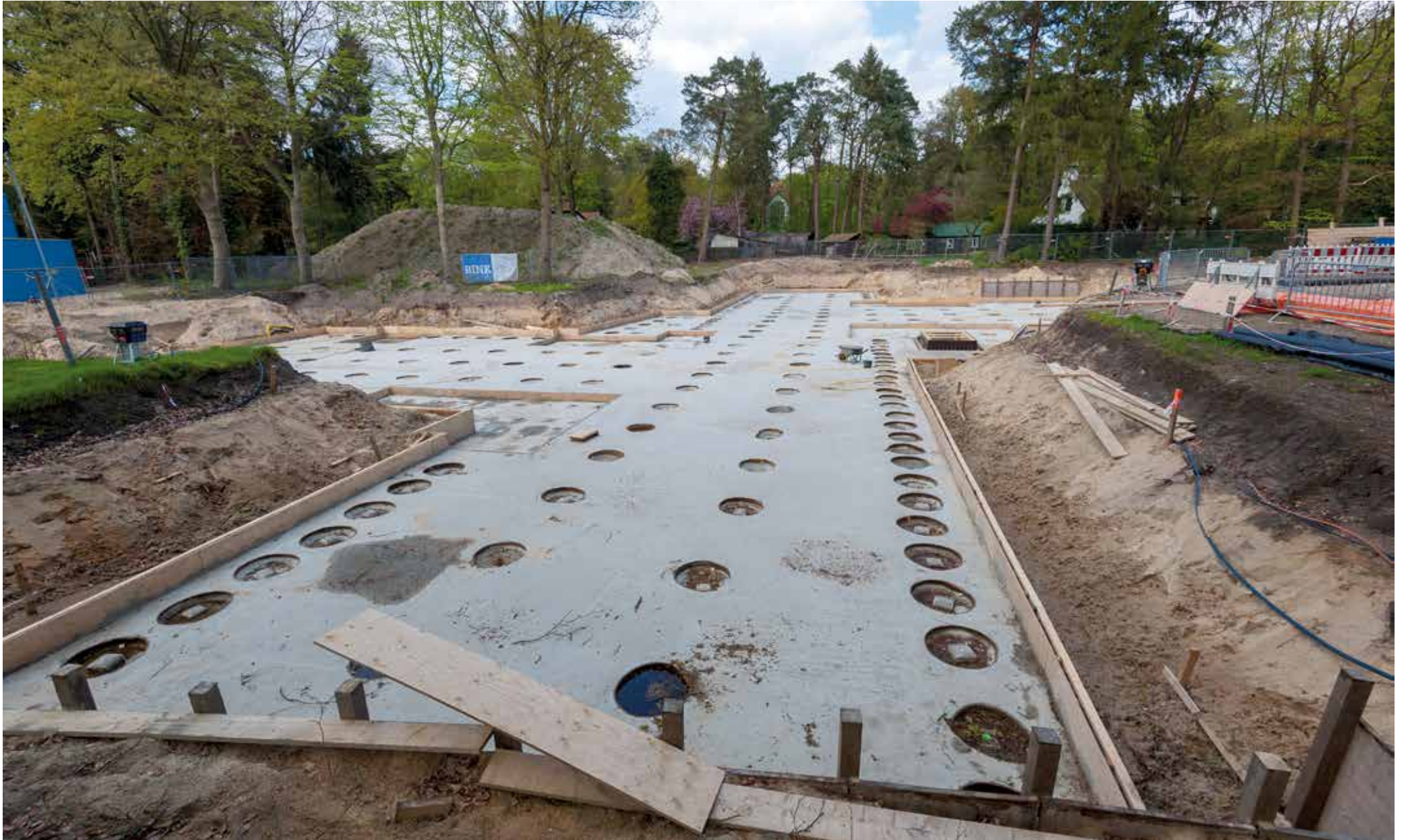
Op deze foto is een goed overzicht te zien van de hele footprint van het gebouw, met palen, werkvloer en randbekisting
