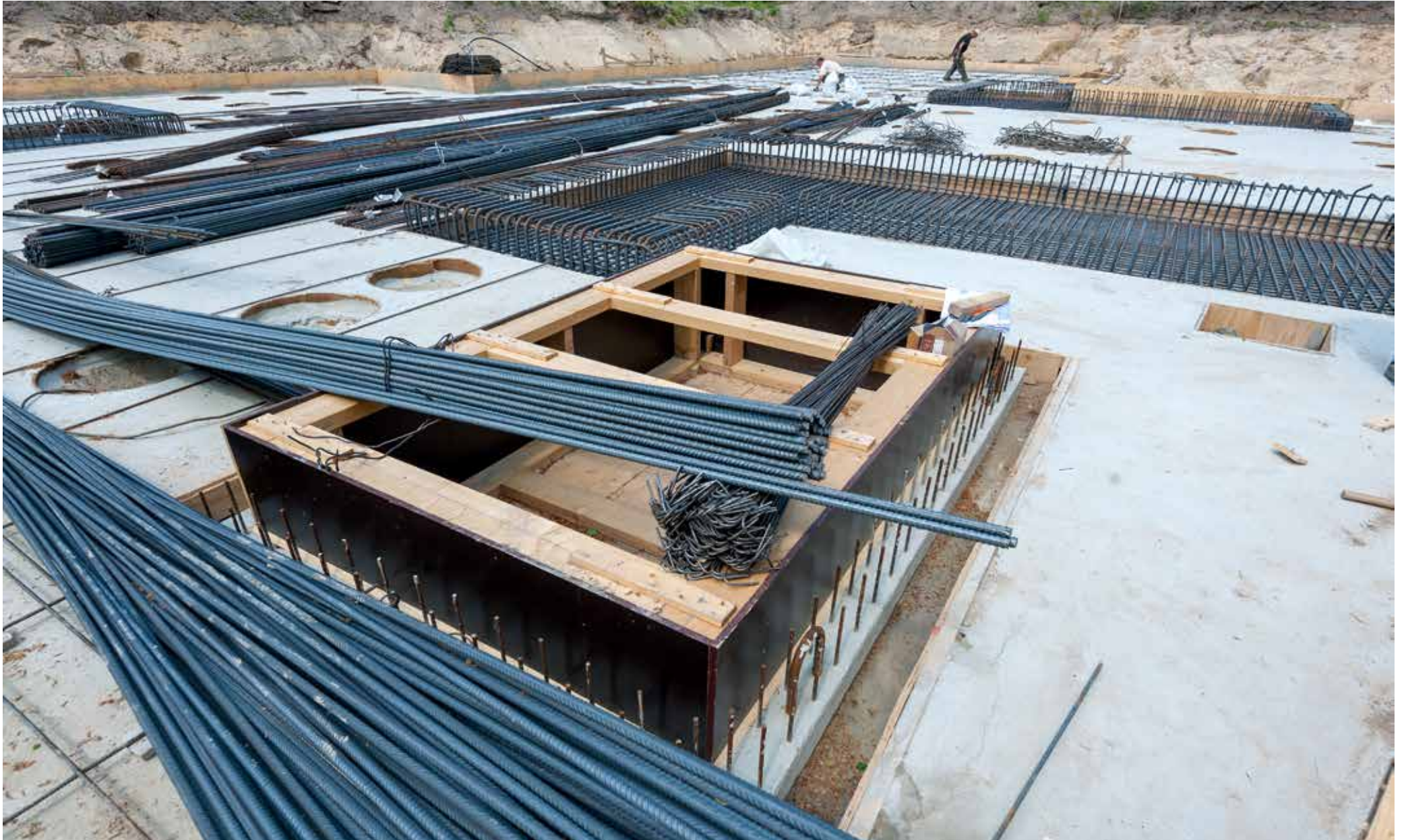
Een imposante hoeveelheid wapeningsstaal voor de keldervloer wordt aangevoerd
