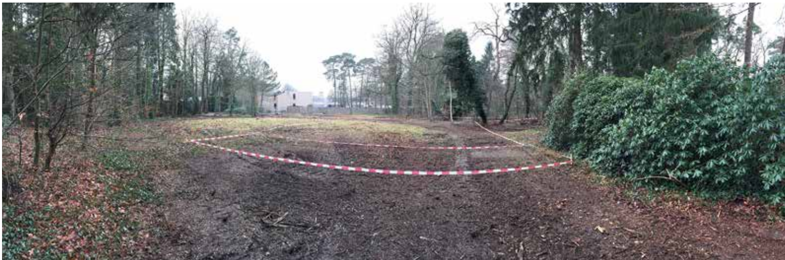
Bouwvlak vrijgemaakt en gemarkeerd – het gebouw past
