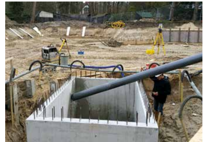
De liftput prefab geplaatst en met water verzwaard
