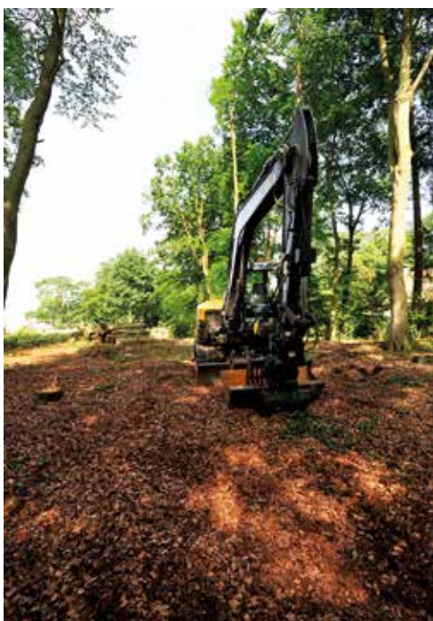
Het vlakmaken van het terrein
