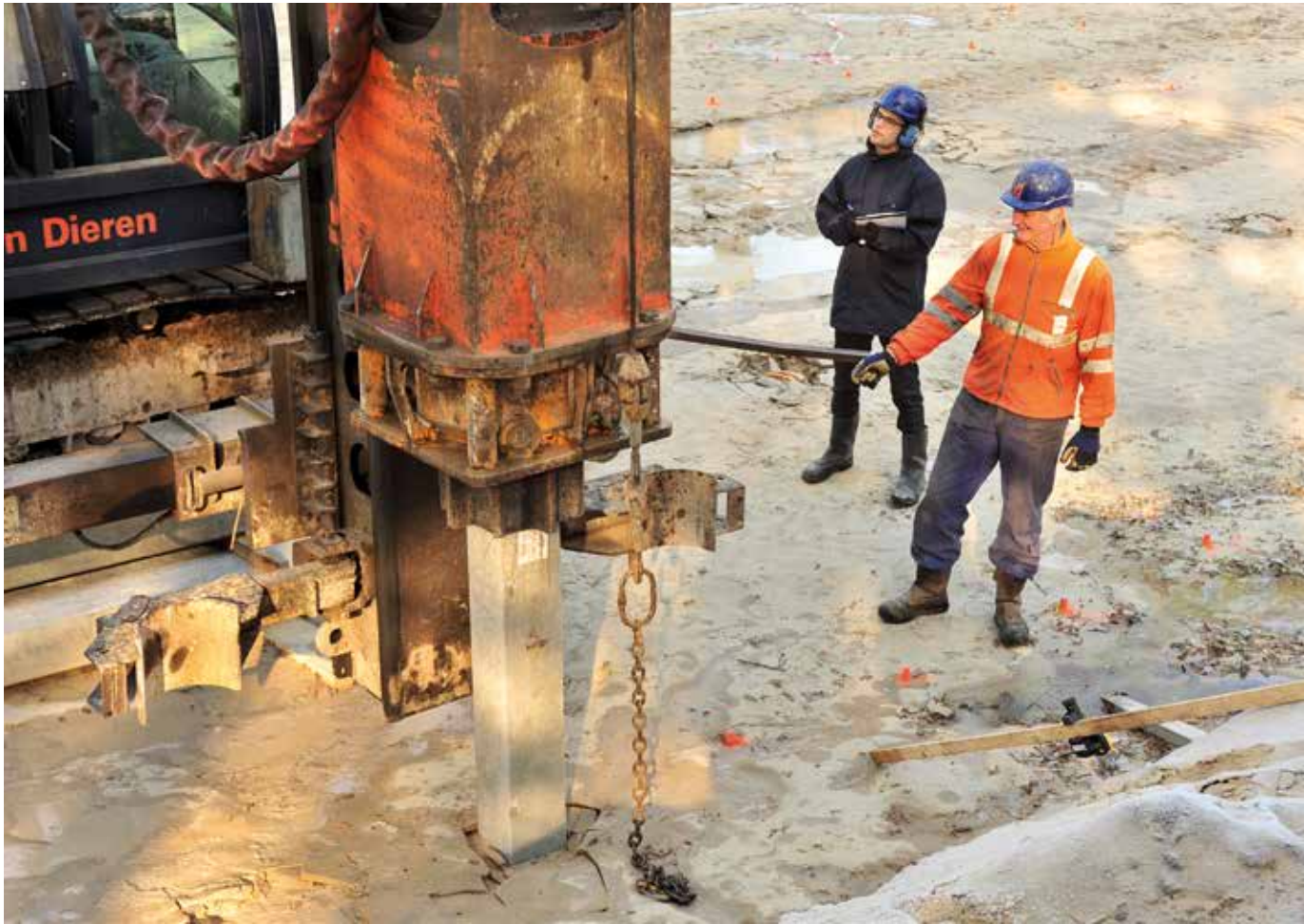
Het heiwerk - vlak voor stilleggen van de bouw
