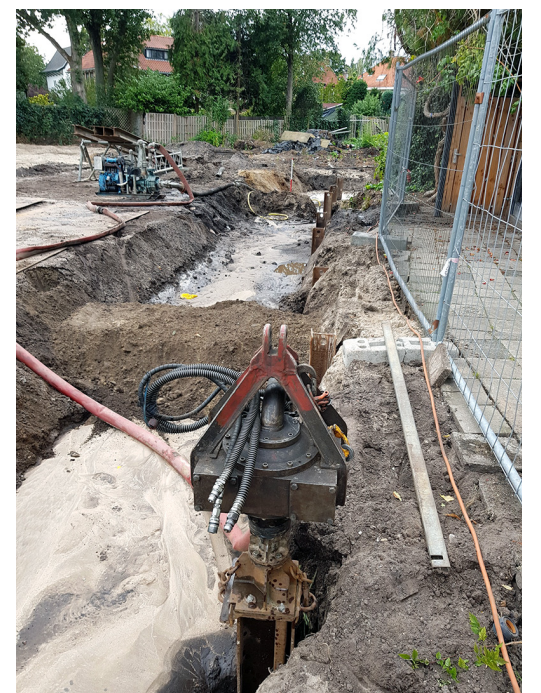
Het intrillen van de 'berliner wand'.
