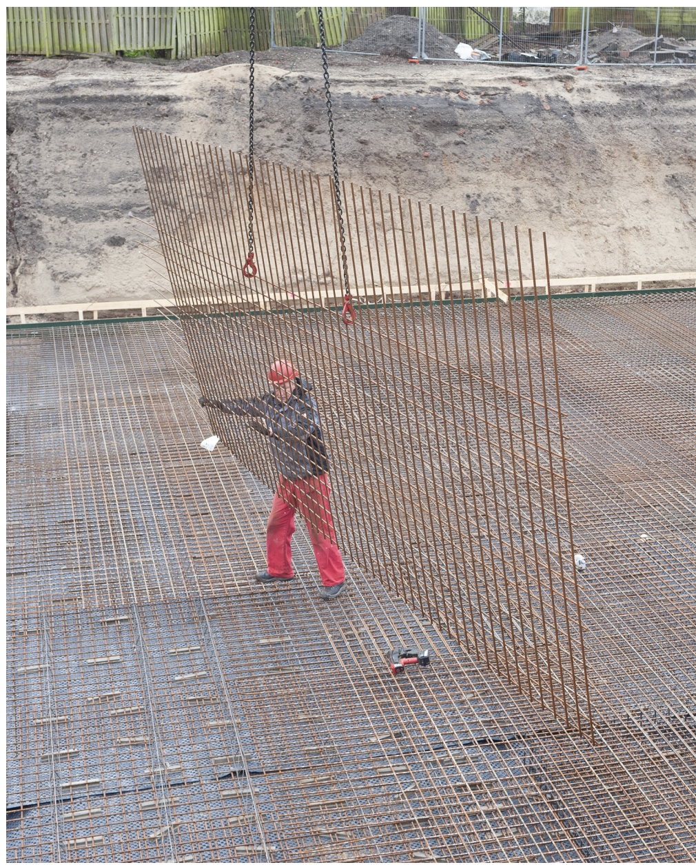
De keldervloerwapening wordt gelegd.
