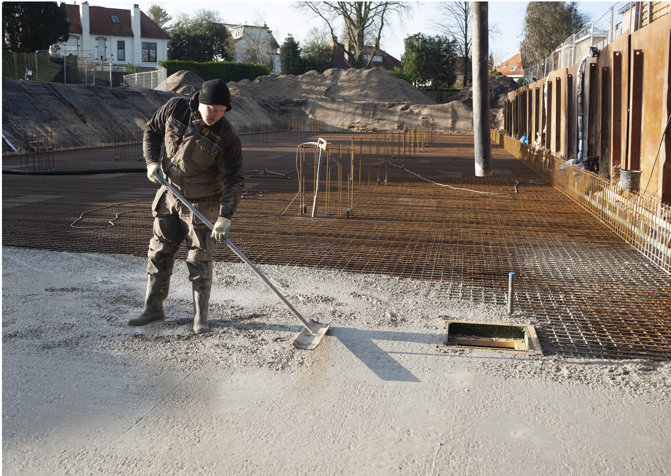
En gladgestreken. De uitsparing is voor de pomp van de inrit.
