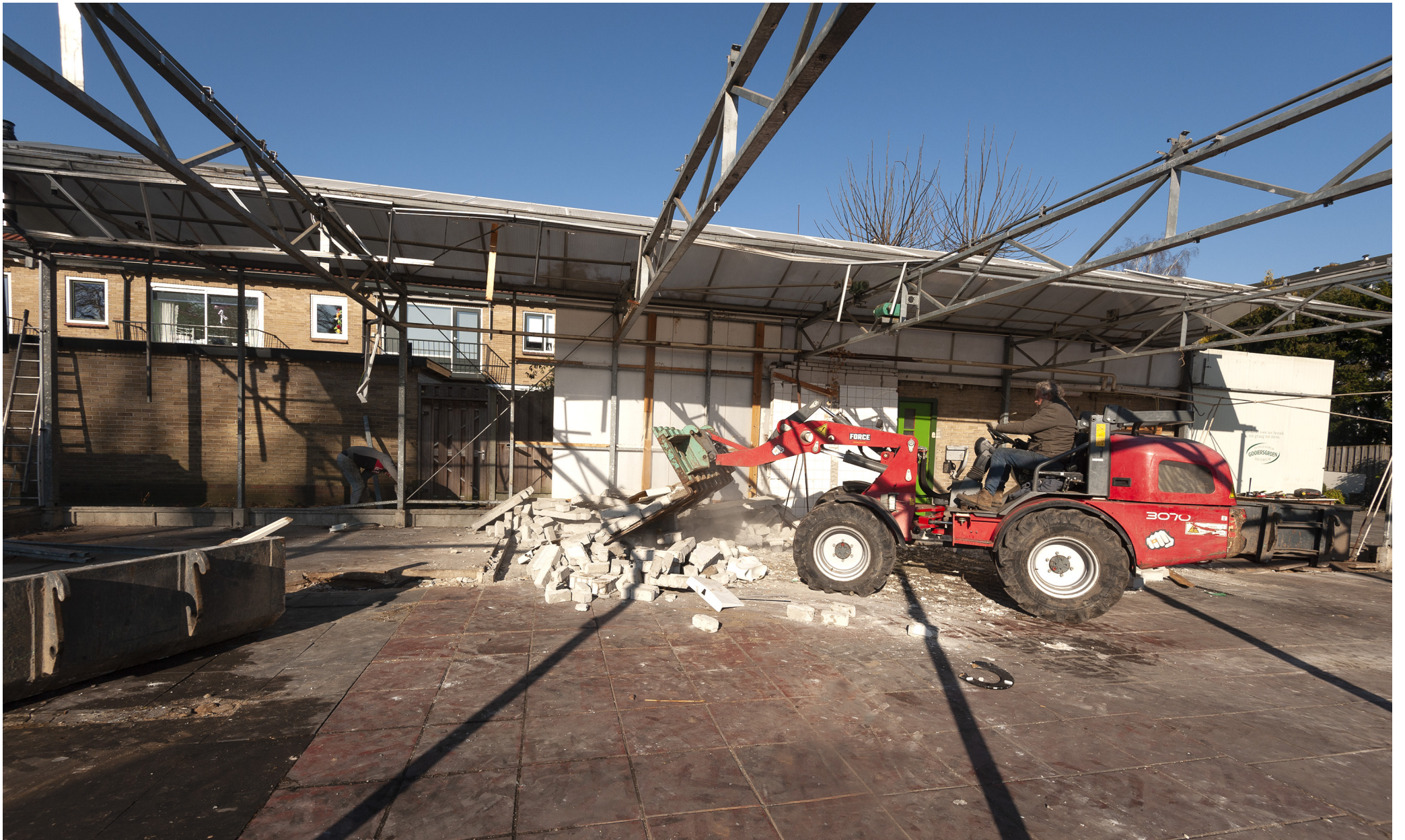
De kas is zorgvuldig gedemonteerd; de gemetselde delen zijn gesloopt.
