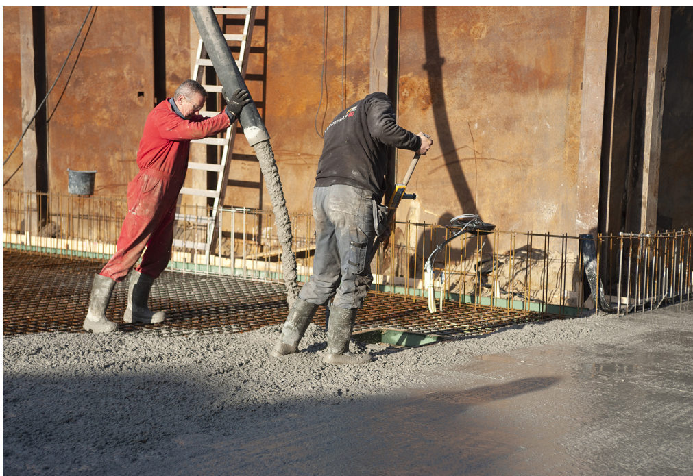
De vloer wordt gestort.
