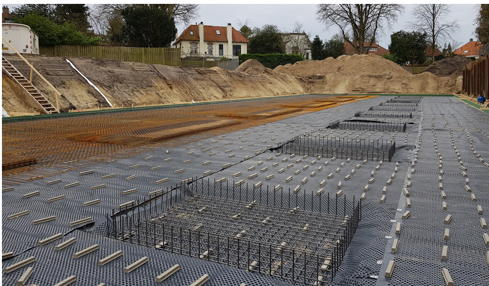
Keldervloerwapening met versterkte delen voor de kolommen.
