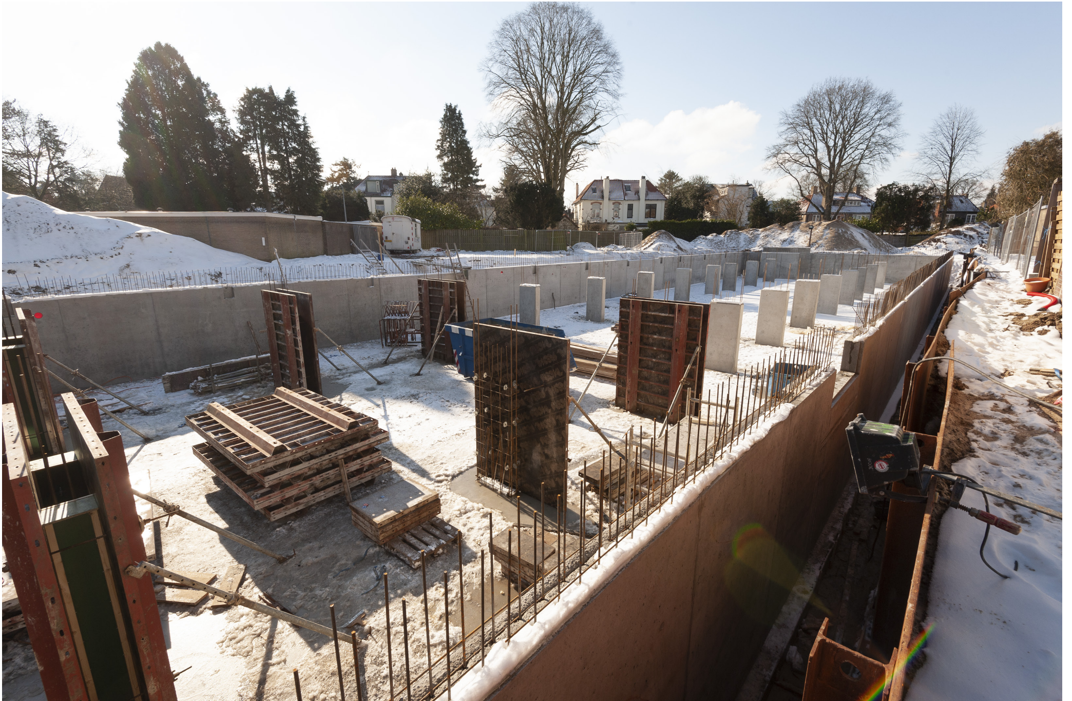
Vorstverlet. Wanden en kolommen grotendeels gereed. Zodra het kon werden de laatste kolommen gestort.
