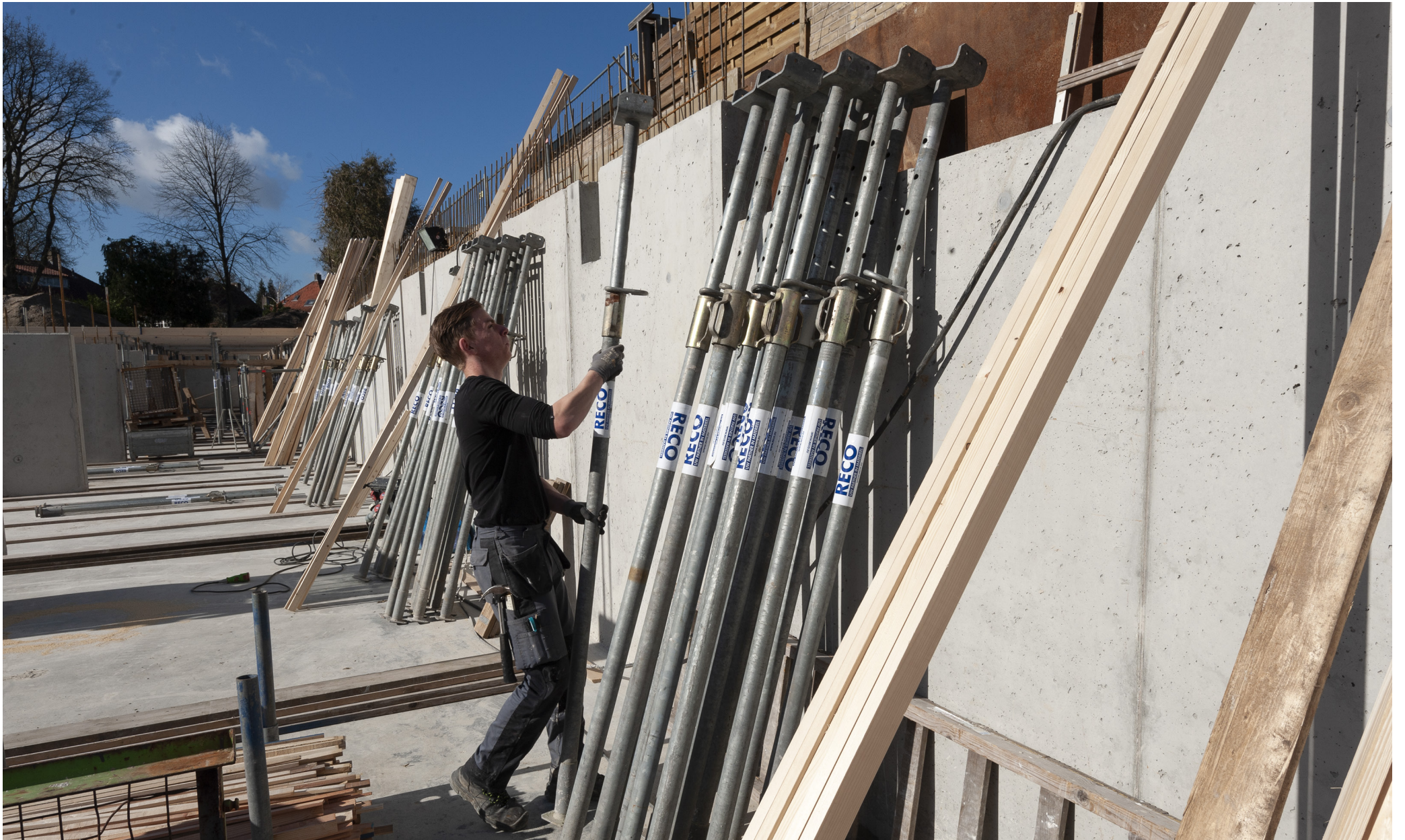
De stempels voor het kelderdak staan gereed.
