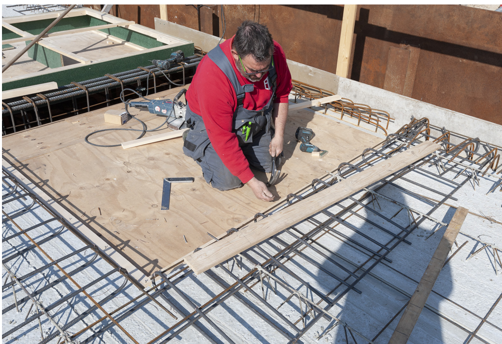
Ron aan het werk op de wat de vloer moet worden.
