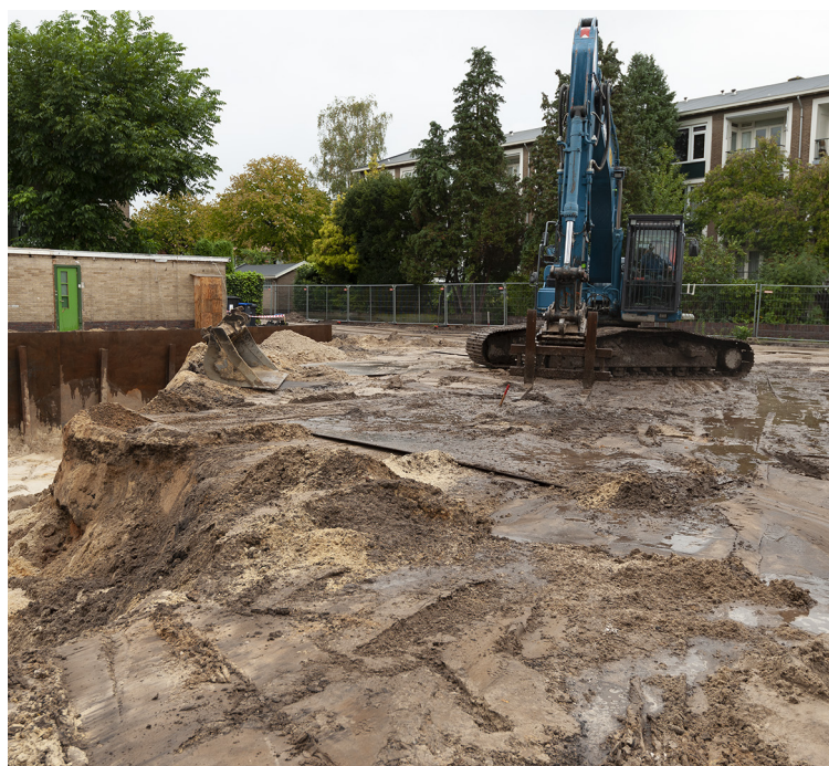
Het graven van de bouwput. Meer dan 6.000 m 3 zand werd afgevoerd.
