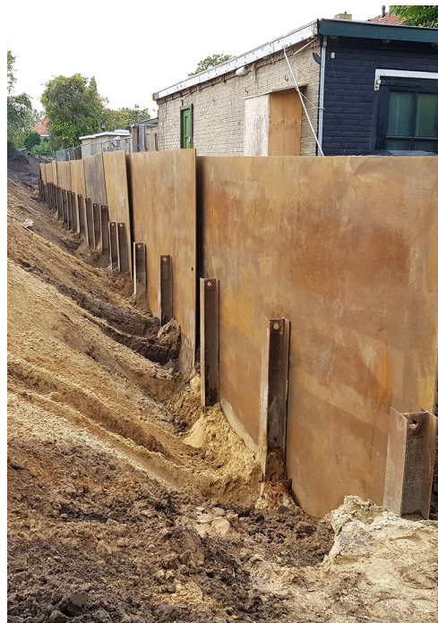
De berliner wand als grondkering.
