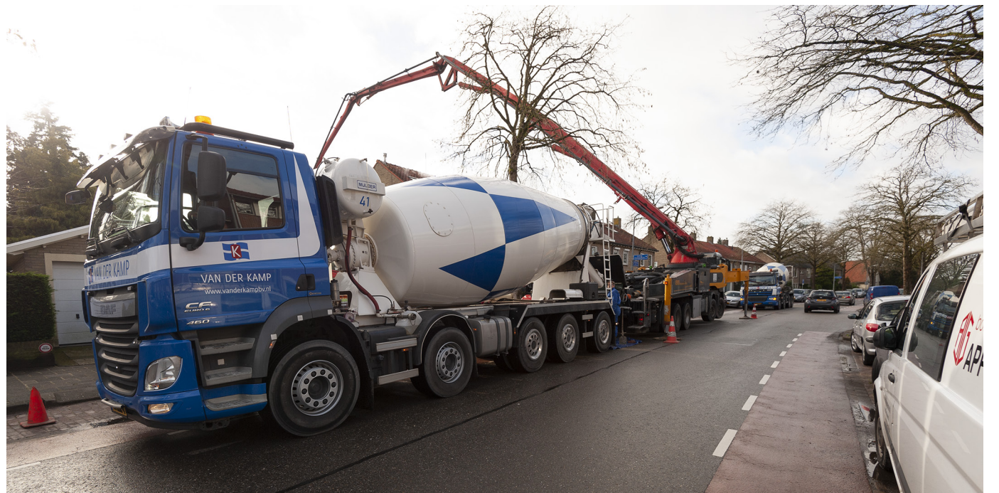
Spectaculaire dagen met de betonpomp en betonmortelwagens op de Van Riebeeckweg.
