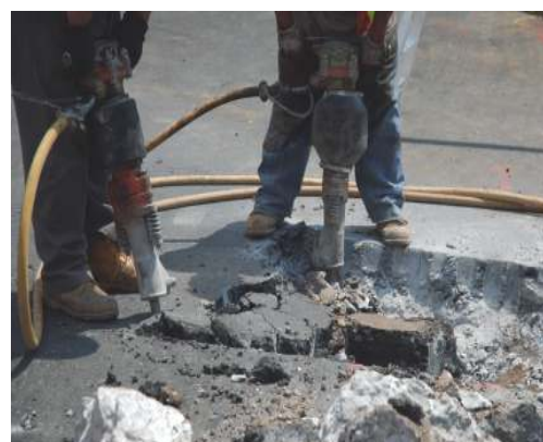
F157: Luchthamer voor het hakken in beton of asfalt.
