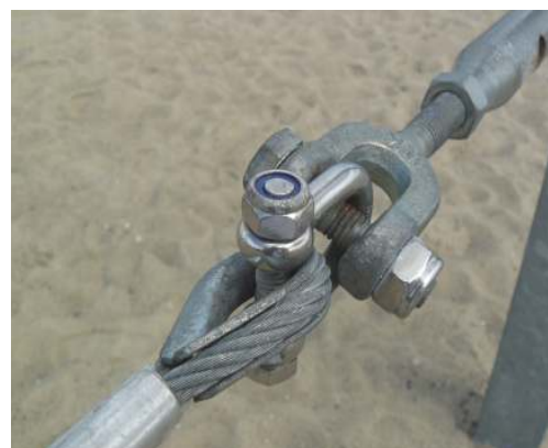
F174: Kettingwerk zoals sluitingen moet van voldoende kwaliteit zijn.
