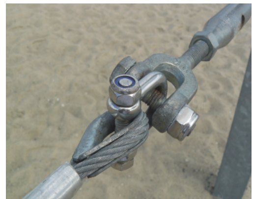
F174: Kettingwerk zoals sluitingen moet van voldoende kwaliteit zijn.
