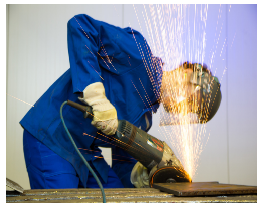
F148: Vonken bij slijpen kunnen brand of explosie veroorzaken.
