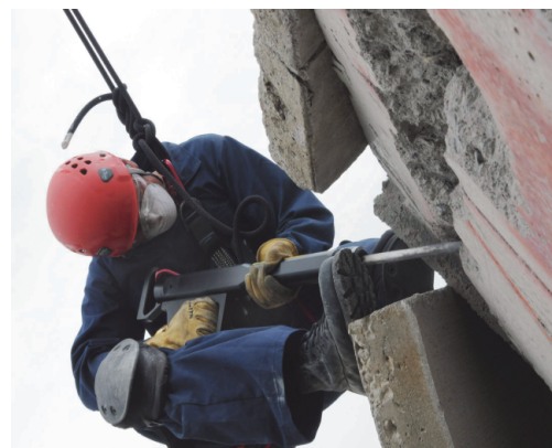
F48 : Bij het gebruik van pneumatische boorhamers ontstaan hand- en armtrillingen.
