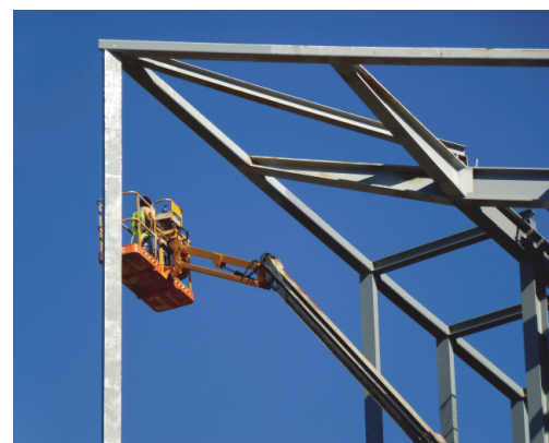
F16: Voor het werken op hoogte is vaak een aanvullende werkvergunning nodig.
