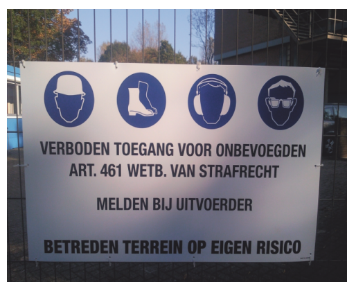
F50: Verplichte PBM's bij het betreden van het bouwterrein.
