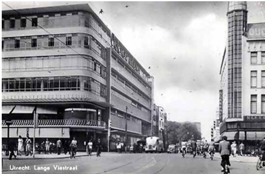
AFBEELDING 4.5 De Lange Viestraat na de verbreding
