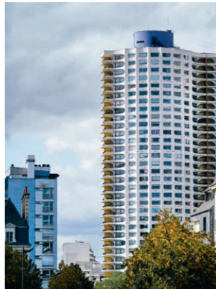
De wijk Bourj-Evêque werd met de grond gelijk gemaakt om er gloednieuwe gebouwen te bouwen.
