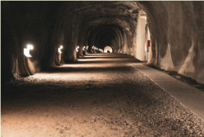
Tot mei 1944 werden sommige van de verbindingstunnels gebruikt om er gevangenen in onder te brengen.
