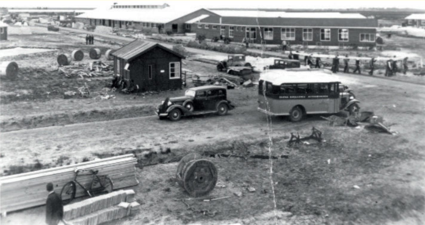
Zicht op de bouw van het 'Centraal Vluchtelingenkamp Westerbork' in 1939.
