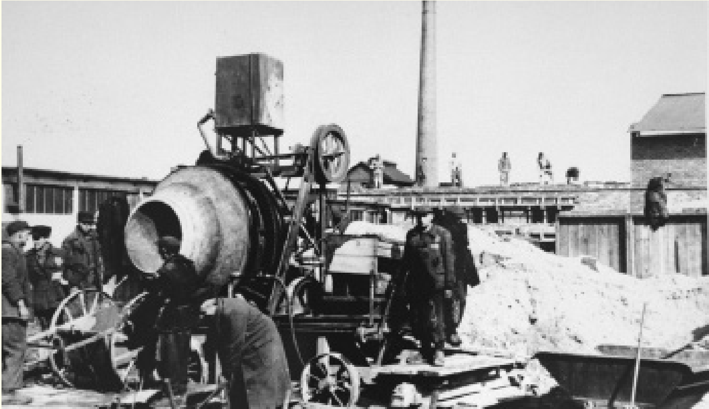
Joodse arbeiders aan het werk bij de bouw van Oskar Schindlers wapenfabriek in Brännlitz.
