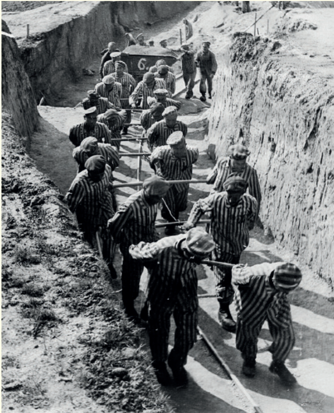
Gevangenen werden ook ingezet voor de bouw en uitbreiding van het kamp.
