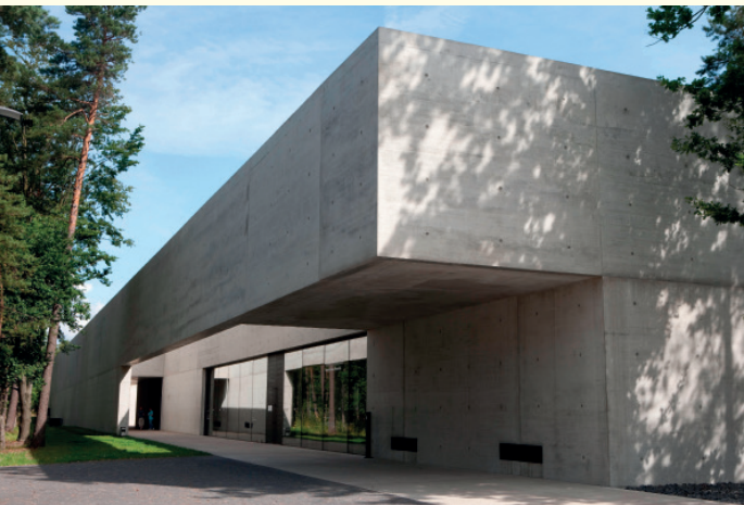
Het documentatiecentrum dat werd opgetrokken aan de rand van het voormalige kamp. Daar waar het 200 m lange, strakke bouwwerk de perimeter van het kamp bereikt, 'zweeft' het letterlijk nog enkele meters de kampsite binnen zonder de aarde eronder te ontheiligen. De permanente tentoonstelling in het gebouw geeft een goede indruk over de gebeurtenissen en het dagelijks bestaan in dit oord tijdens de oorlogsjaren.
